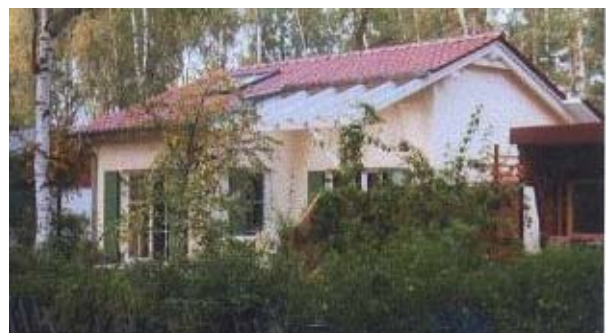
Ansicht Eingang Carport
