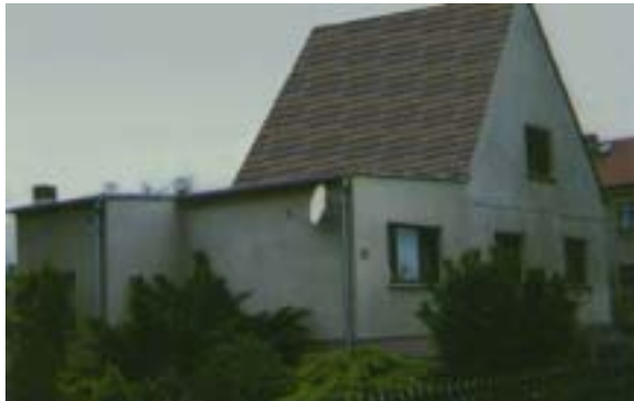
Ansicht Strasse vor Sanierung
