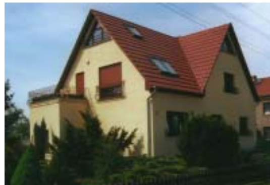
Ansicht Strasse nach Sanierung
