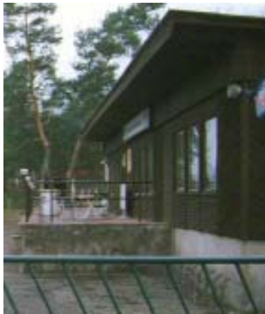
Terrasse vor Sanierung
