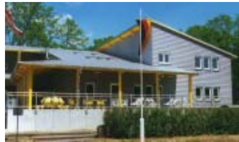
Ansicht nach Sanierung
