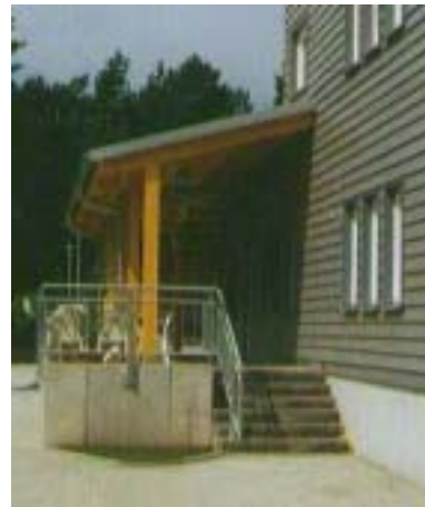
Terrasse nach Sanierung
