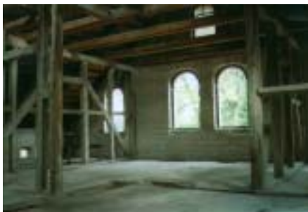
Innenraum vor Sanierung
