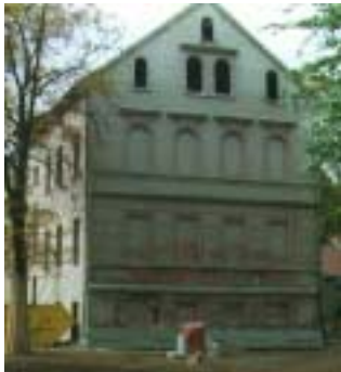
Fassade vor Sanierung
