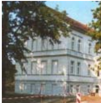
Fassade nach Sanierung
