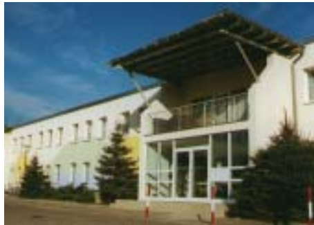
Ansicht nach Sanierung
