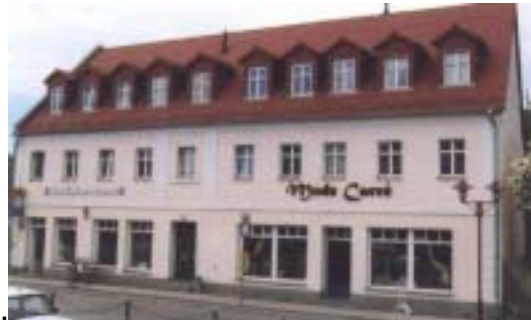
Ansicht nach Sanierung
