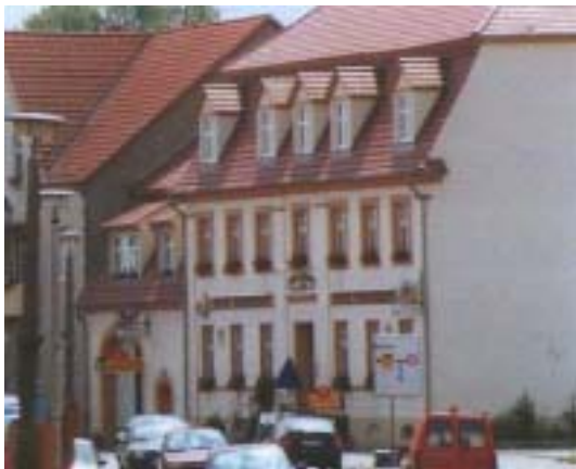
Ansicht Frankfurter Straße
