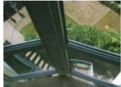
Blick von Treppenhaus in den Innenhof
